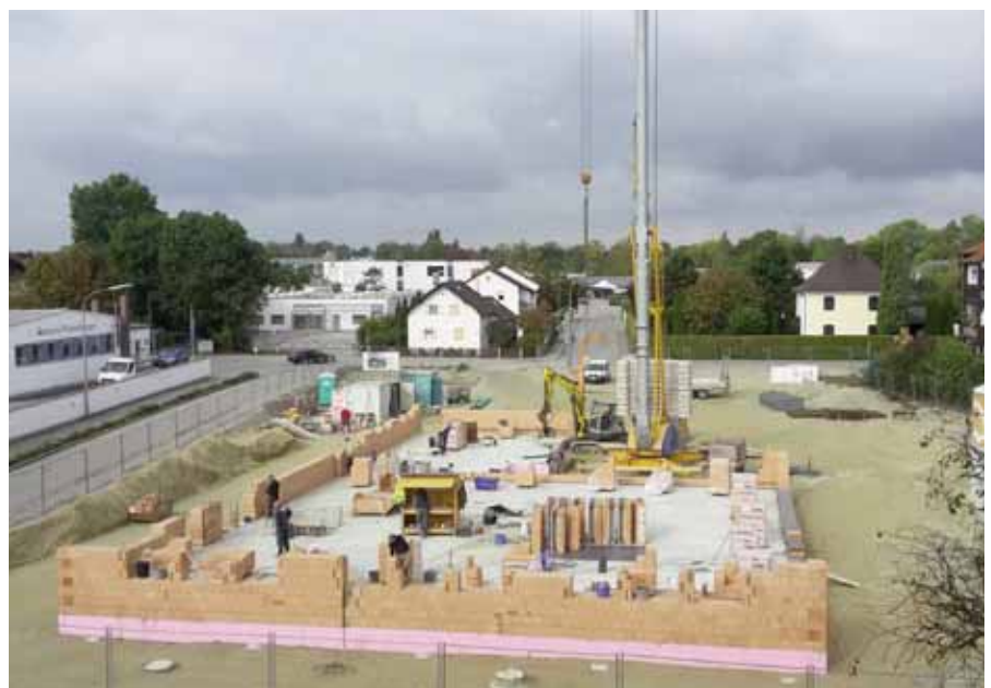
Neubau begonnen – Bodenplatte ausgeführt
