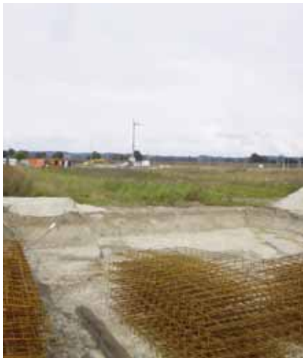
Ein Einfamilienhaus entsteht in der Grillparzerstraße
