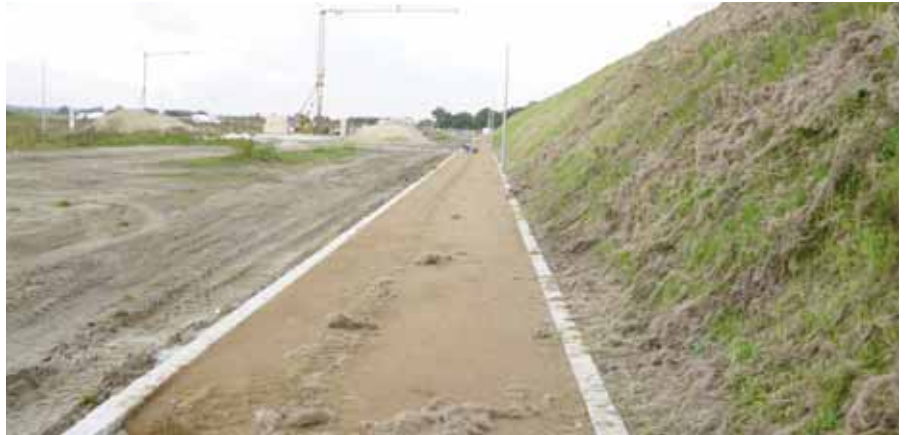
Mineralbetonweg entlang des Lärmschutzwalls zu den Bahngleisen
