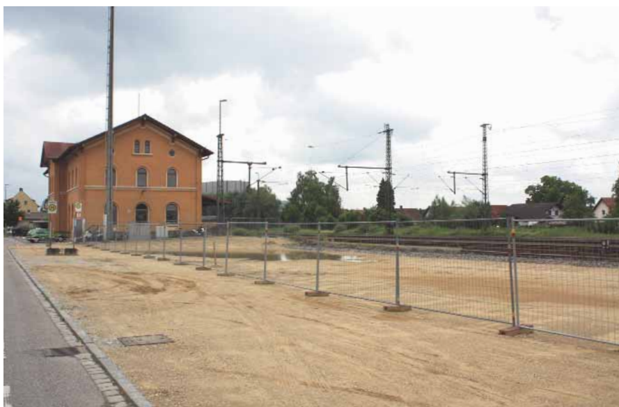
Die Abbrucharbeiten sind vollendet. Hier entsteht das Parkdeck.
