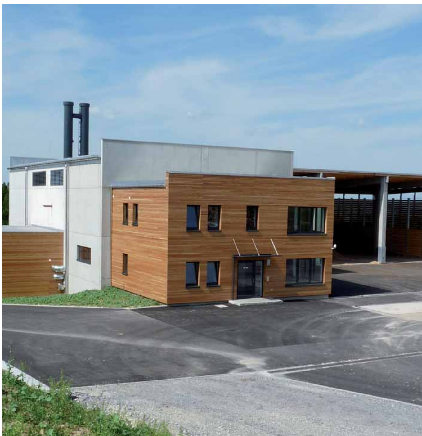
Das neue Biomasse-Heizwerk der Stadtwerke Dingolfing
