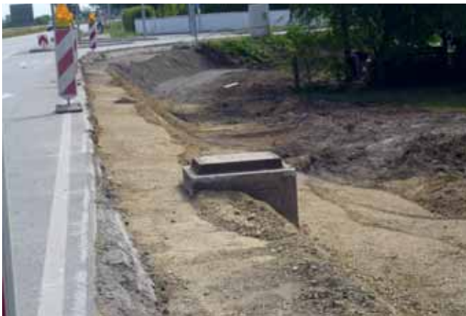
Die Arbeiten im Bereich der Einmündung Kreuzstr./Höller Str. dauern noch an
