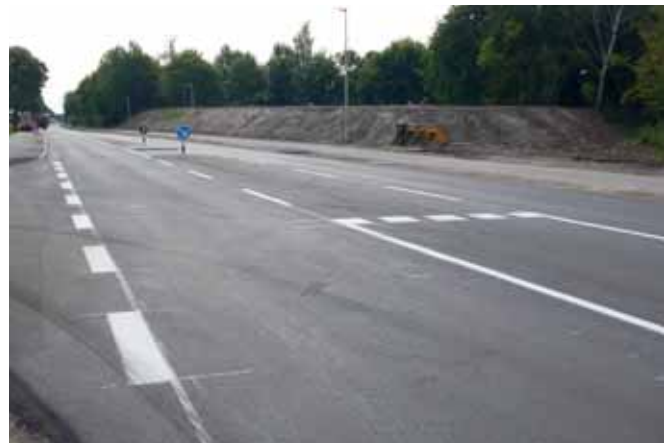
Die fertiggestellte Querungshilfe Flugplatz - lediglich die Bepflanzung fehlt noch
