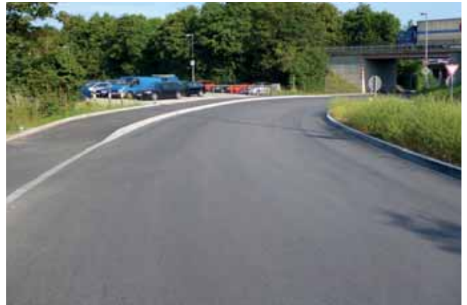
Der neue Geh- und Radweg entlang der Karl-Dompert-Straße, auch hier kommt später wie am gesamten Streckenverlauf eine moderne LED-Strassenbeleuchtung zum Einsatz
