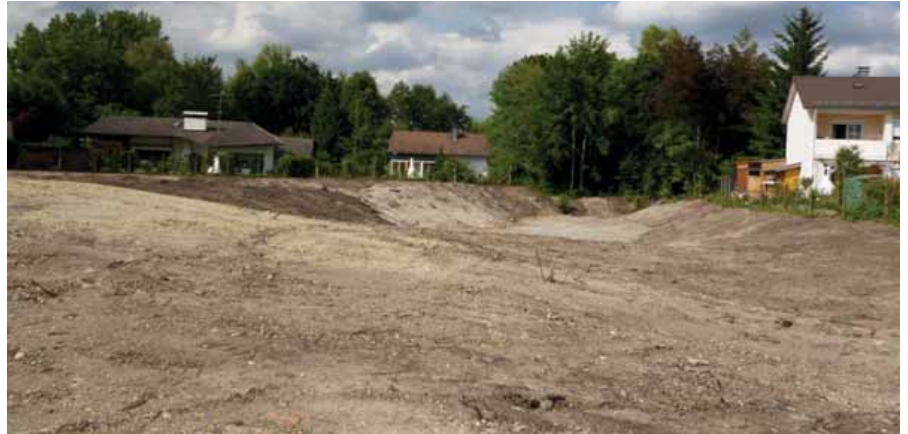
Erste Vorarbeiten des Baugebietes Glogauer Weg sind bereits fertiggestellt
