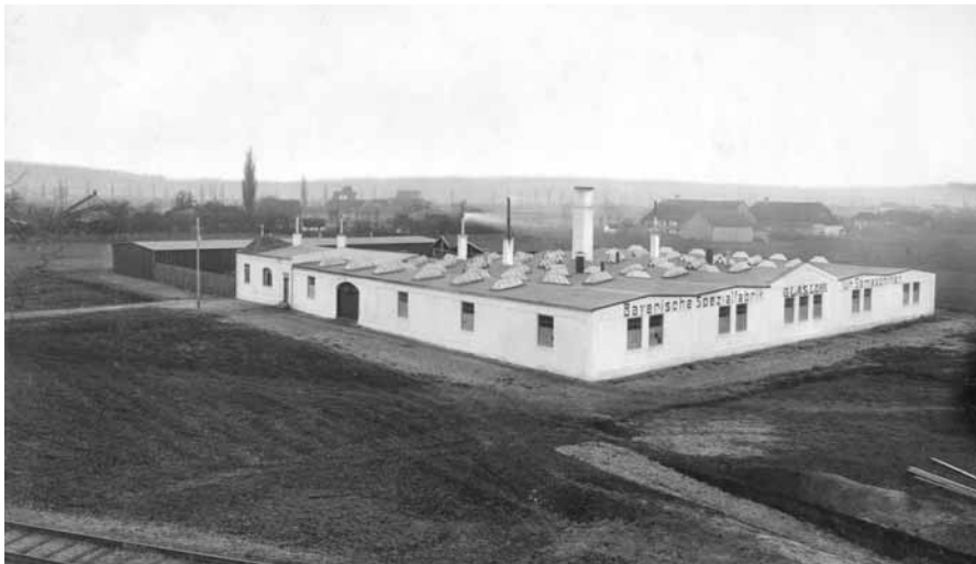
Ansicht der ersten Fabrikanlage der Firma Glas & Lohr, Bayerische Spezialfabrik für Sämaschinen, 1908
