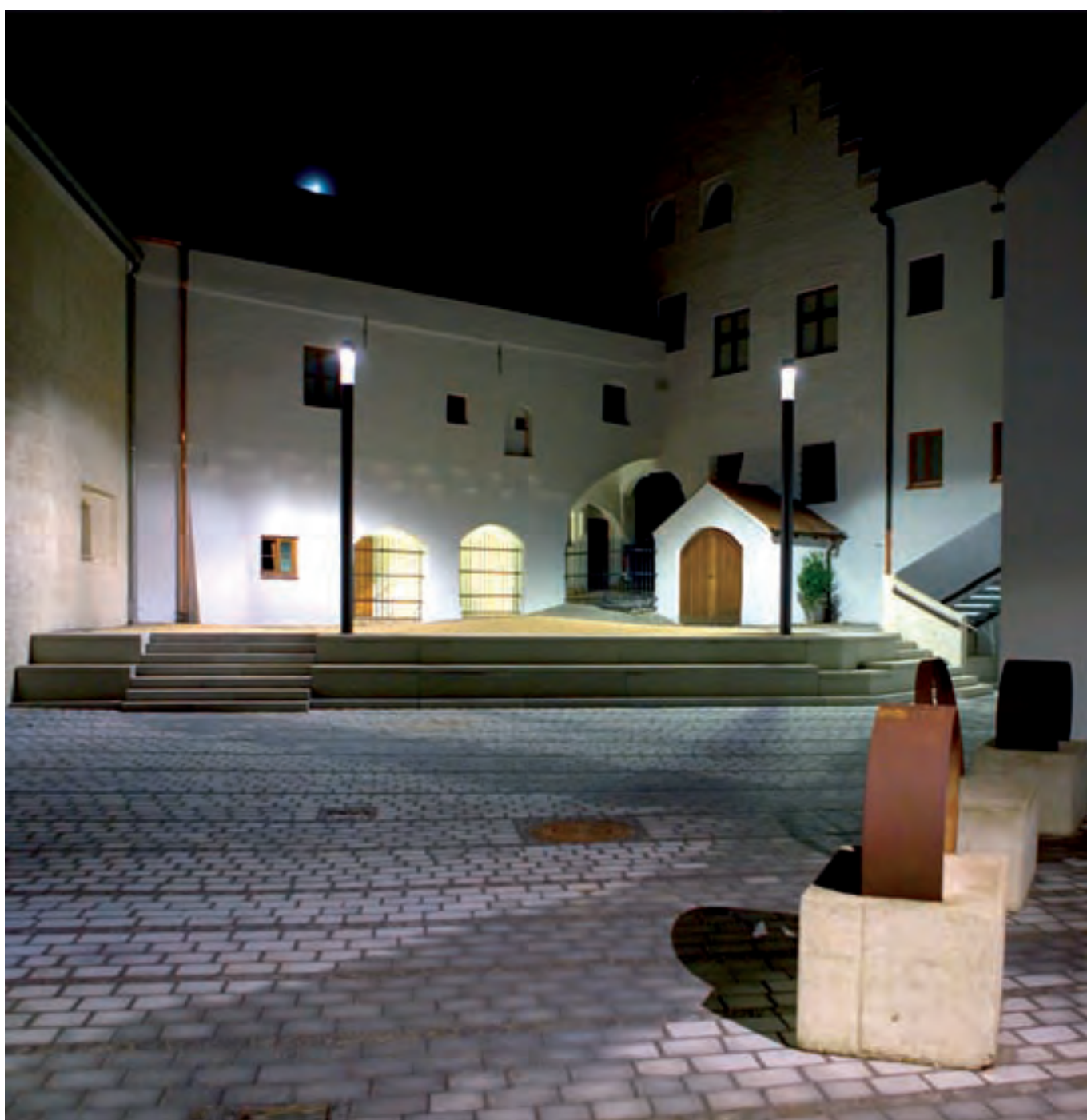
Industriemuseum Dingolfing - Innenhof Steinweg
