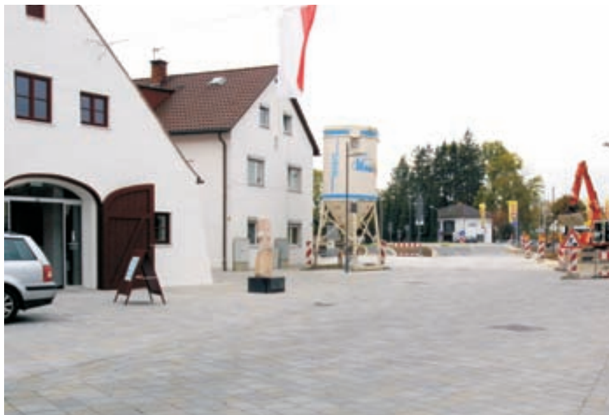
Umgestaltung Zugang Fischerei abgeschlossen
