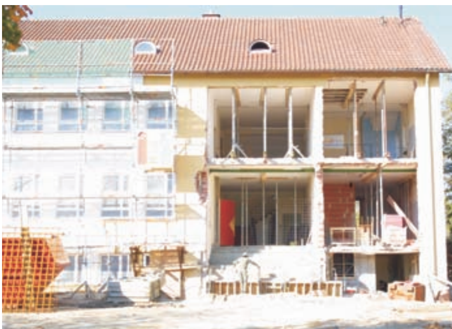
Derzeit Baustelle – Die Grundschule Teisbach Rechts neben dem Treppenaufgang wird ein Aufzug installiert
