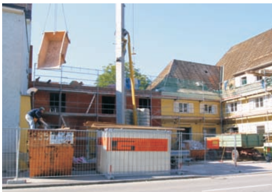
Zur Zeit Baustelle – Das alte Postgebäude
