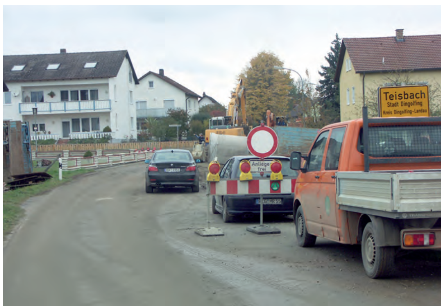
Blick aus Richtung Oberteisbach: hier entsteht die neue Schickane
