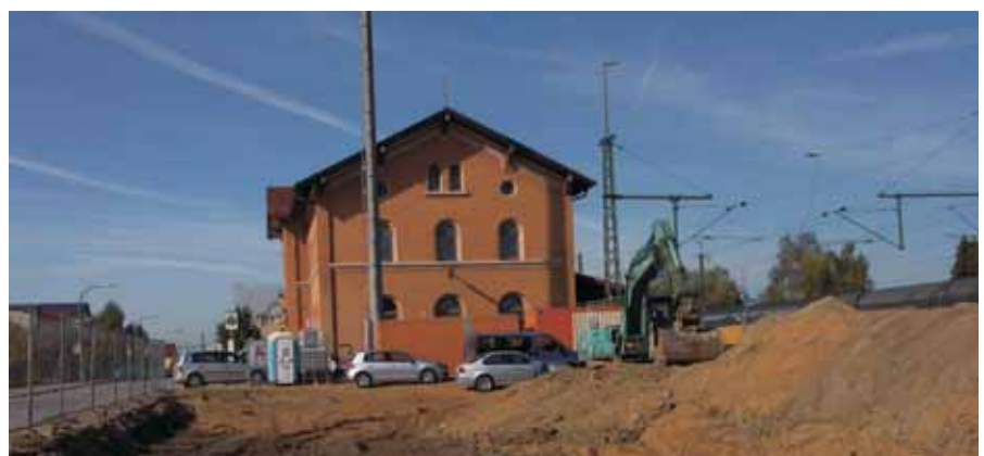
Baustelle Parkdeck Bahnhof
