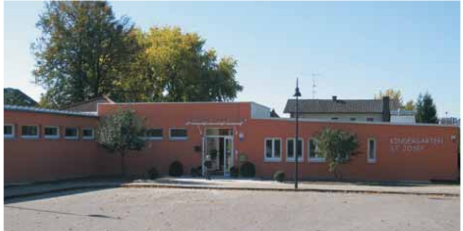
Saniert: der Kindergarten St. Josef
